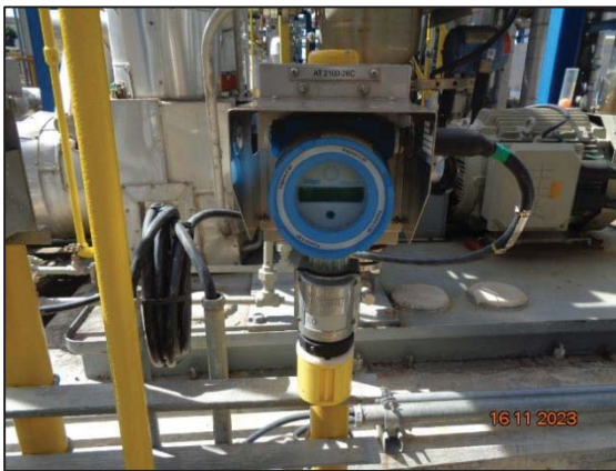
รูปที่ 3.52 Flammable Gas Detector
