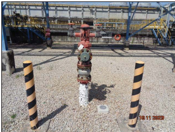
รูปที่ 3.44 Fire Water Hydrant
