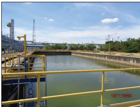
รูปที่ 3.12 Final Check Basin (F-1803)
