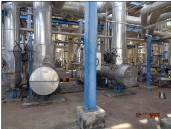
รูปที่ 3.14 Acoustic Insulation (G-624 A/B)
