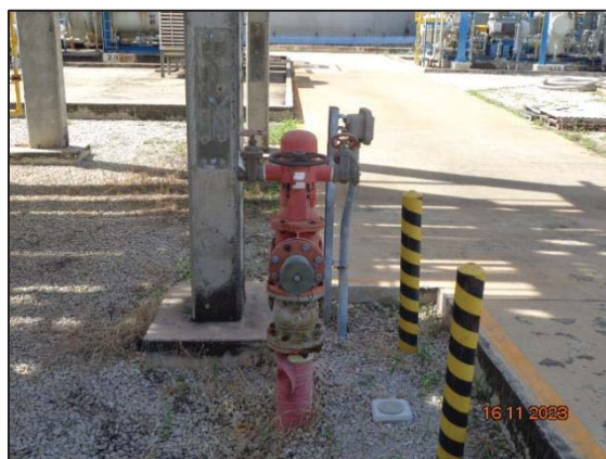
รูปที่ 3.43 Fire Water Monitor
