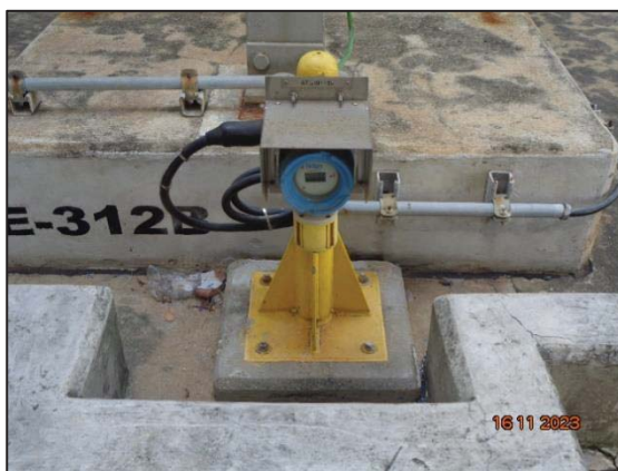
รูปที่ 3.54 Hydrocarbon Gas Detector
