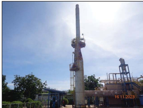
รูปที่ 3.1 Waste Heat Boiler
