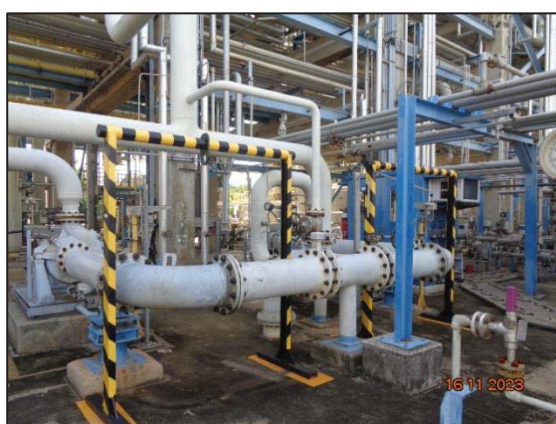
รูปที่ 3.37 Check Valve
