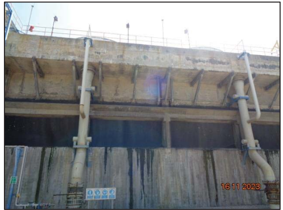
รูปที่ 3.11 Cooling Water Blowdown
