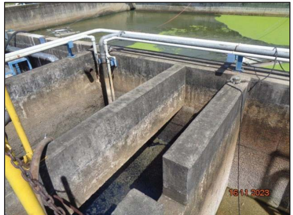
รูปที่ 3.9 Wastewater Holding Pit (F-1801)
