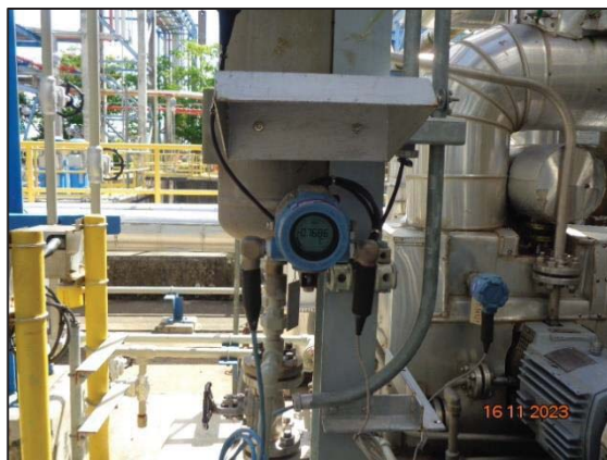
รูปที่ 3.40 Pressure/Temperature Indicator
