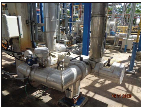
รูปที่ 3.36 ฉนวนหุ้มอุปกรณ์การผลิต เอทิลีนออกไซด์
